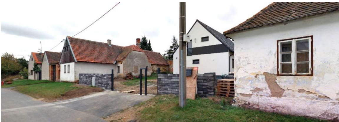
Příklad nedodržení jednotné stavební čáry v souvislé venkovské zástavbě
